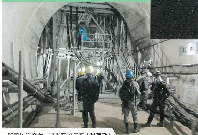
超高压送電ケーブル布設工事（洞道部）
