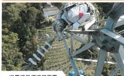
送電線鉄塔塗装工事
