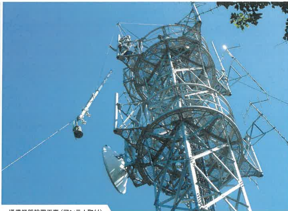
通信機器設置工事 (アンテナ取付)
