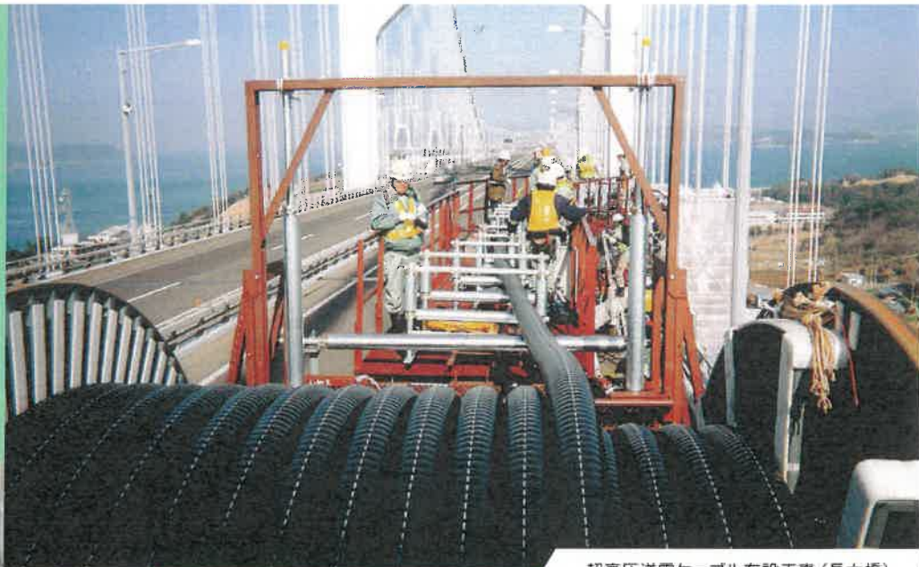
超高压送電ケーブル布設工事（長大橋）
