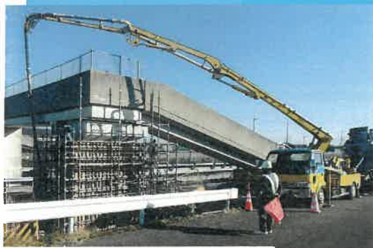
南川歩道橋改良工事（徳島市）
