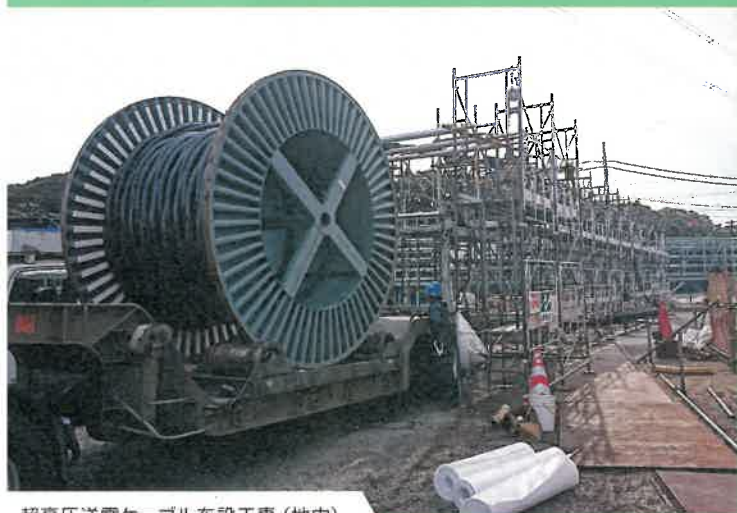
超高压送電ケーブル布設工事（地中）
