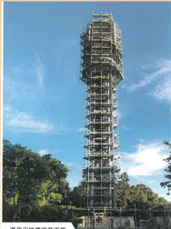
通信用鉄塔塗装工事
