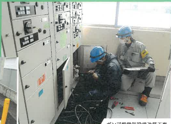
ポンプ場電気設備改築工事
