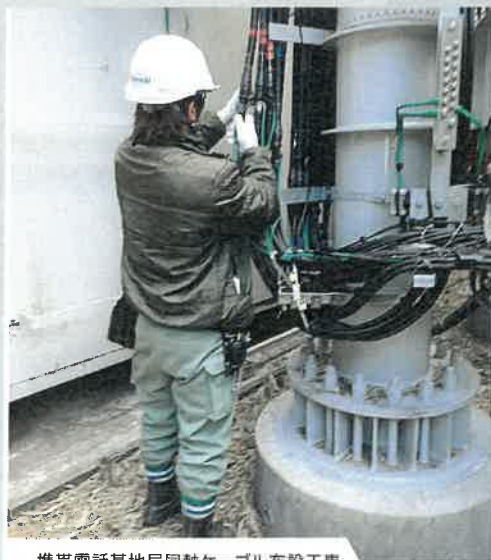
携帯電話基地局同軸ケーブル布設工事
