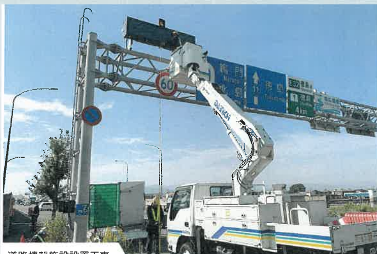
道路情報施設設置工事
