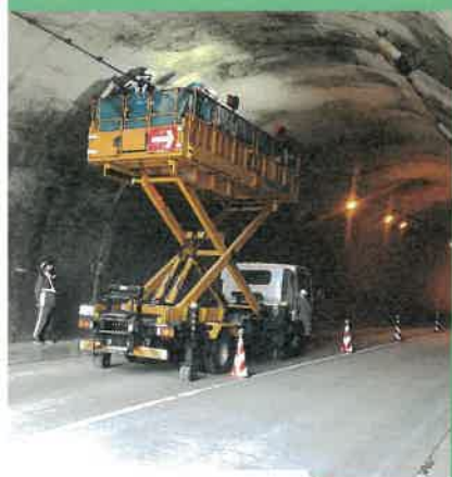
トンネル照明LED化設備工事
