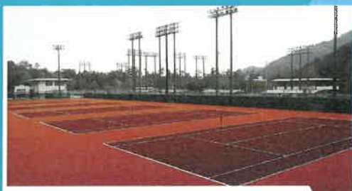
日峯大神子広域公園テニスコート修繕工事（徳島県）
