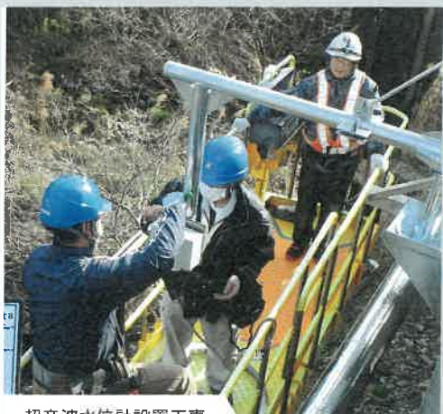
超音波水位計設置工事
