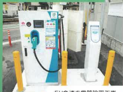
EV急速充電器設置工事
