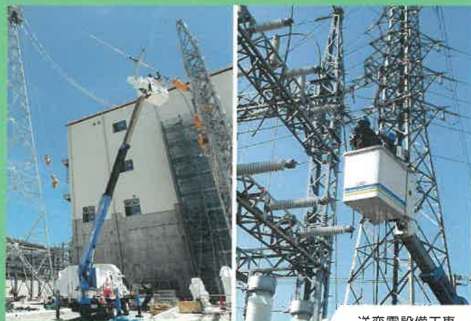
送変電設備工事
