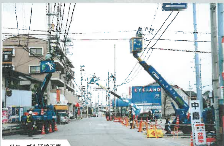
光ケーブル延線工事
