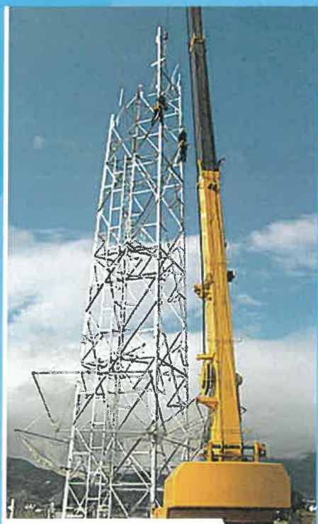
携帯電話無線中継所新設工事
