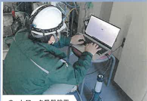
ネットワーク機器設置
