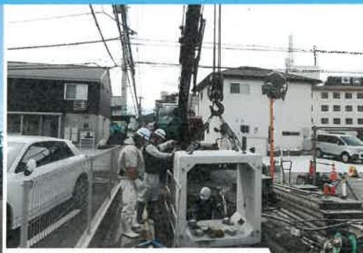
田宮西都市下水路築造工事（徳島市） （オープンシールド工法）
