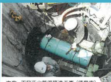
末広一丁目污水管渠築造工事（徳島市） （推進工事）
