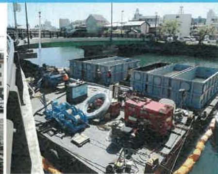
三ツ合橋耐震化工事（徳島市）
