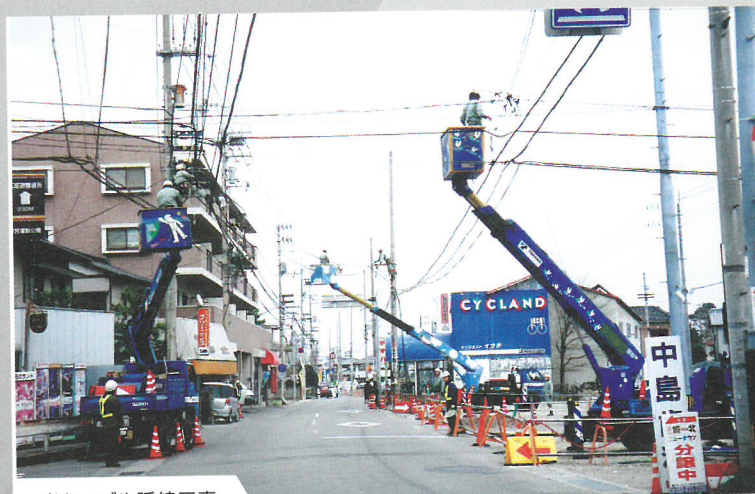
光ケーブル延線工事
