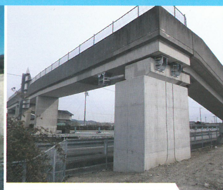
南川歩道橋改良工事（徳島市）
