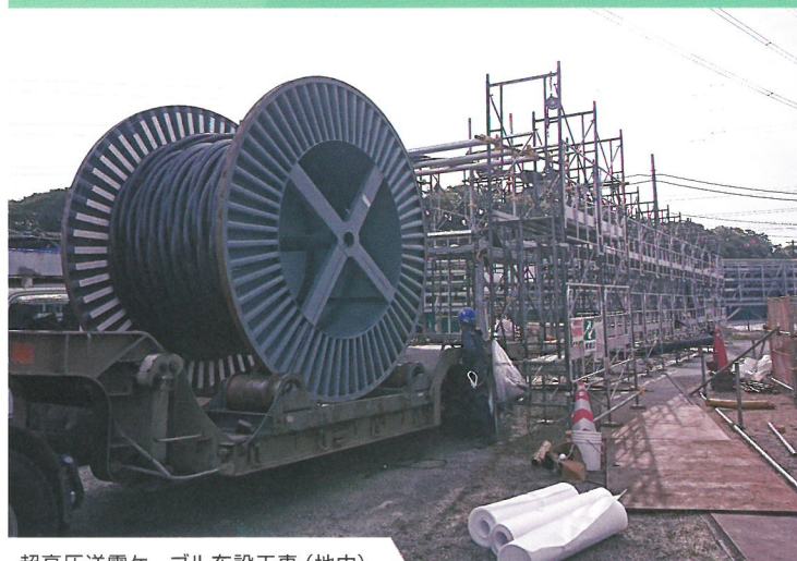
超高圧送電ケーブル布設工事（地中）
