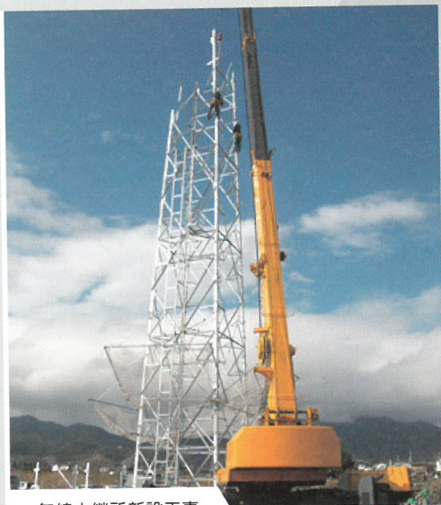
無線中継所新設工事
