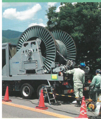
高圧配電ケーブル撤去工事（地中）
