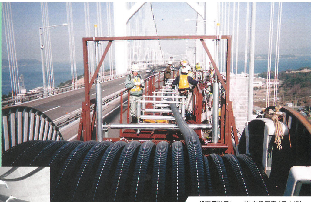
超高圧送電ケーブル布設工事（長大橋）
