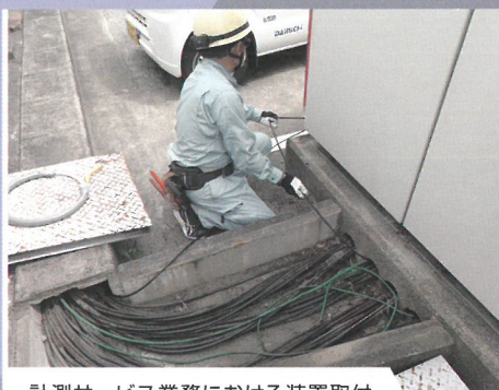
計測サービス業務における装置取付
