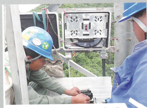
光ファイバー複合架空地線 (OPGW) 工事
