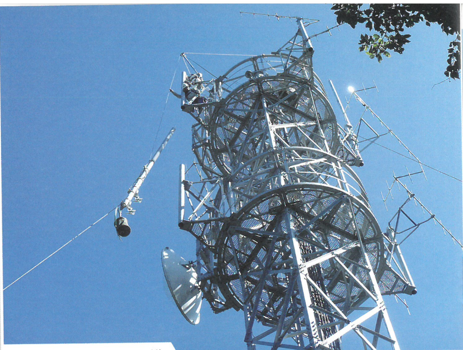
通信機器設置工事 (アンテナ取付)
