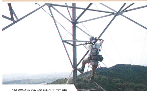
送電線鉄塔塗装工事
