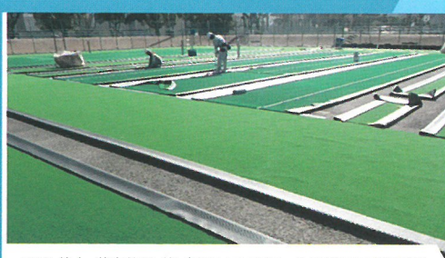
H28 徳土 蔵本公園 徳・庄町1 テニスコート修繕工事（徳島県）
