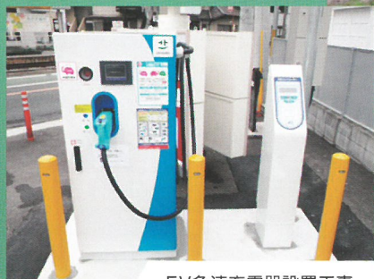
EV急速充電器設置工事
