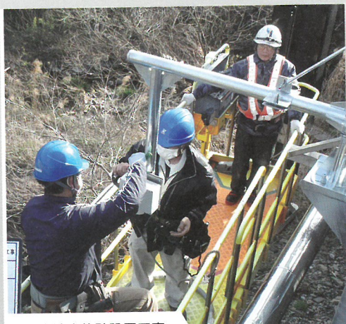
超音波水位計設置工事
