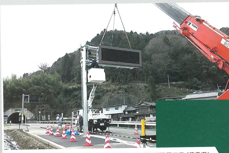
H30三土 大川辻線他 三・井川辻他 道路情報表示板設置工事 (徳島県)
