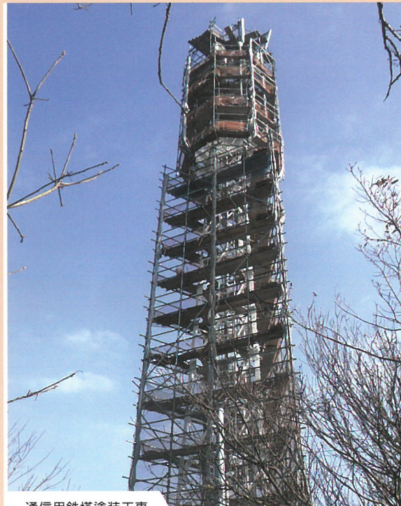
通信用鉄塔塗装工事
