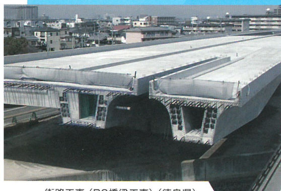
街路工事（PC橋梁工事）（徳島県）
